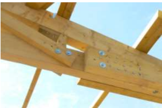
Bild 7: Anschluss Untergurt an Obergurt bei Fachwerk-Dübelbinder Dachneigung 14°
