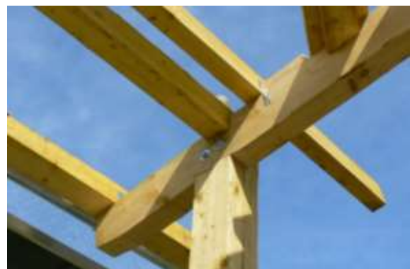
Bild 8: Anschluss Giebelstütze, Giebelrähm
