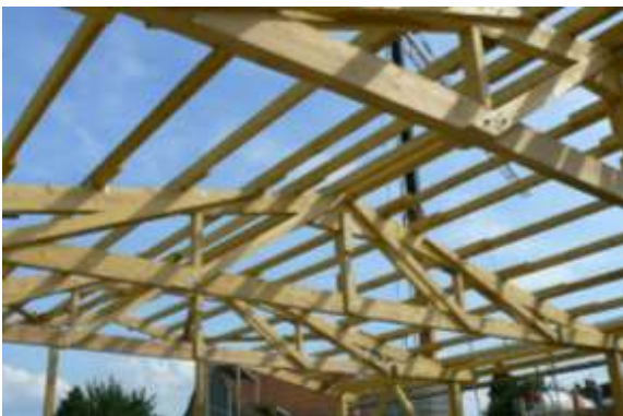
Bild 5: Fachwerk-Dübelbinder mit Koppelfetten, Dachneigung 14°
