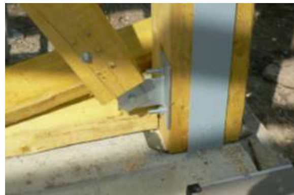
Bild 4: Detail Einspannung der zweiteiligen Holzstütze mit IPE-Profil
