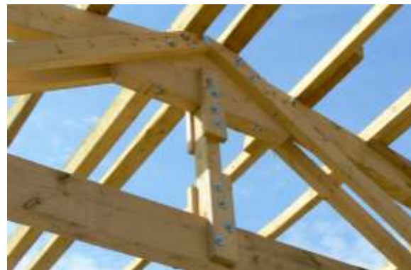
Bild 6: Firstknoten eines Fachwerk-Dübelbinders
