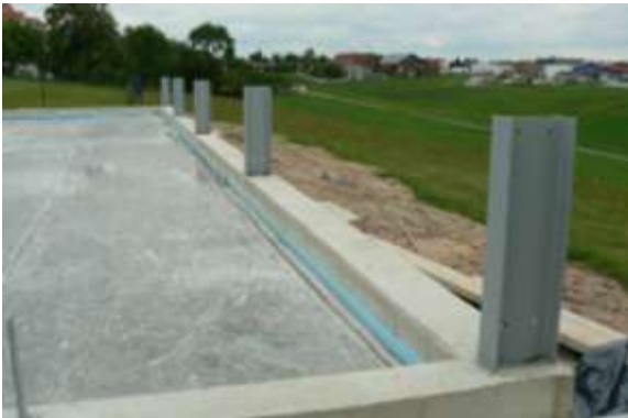
Bild 1: Einbetonierte IPE-Stahlprofile vor der Montage der zweiteiligen Holzstützen
