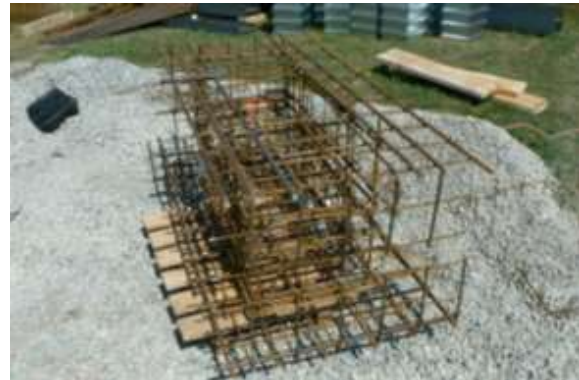
Bild 2: Bewehrungskorb eines Einzelfundamentes vor dem Einbau
