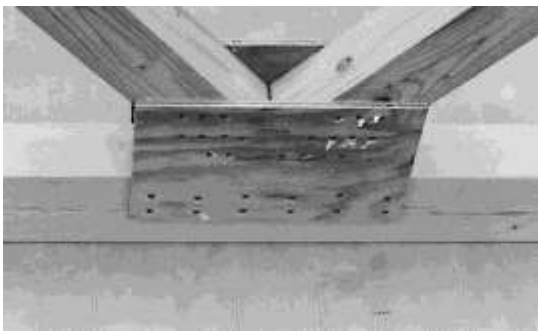
Ausführung mit Sperrholzknotenplatten
